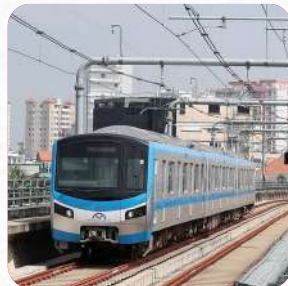
Dự án Metro Bến Thành - Suối Tiên
